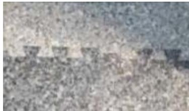
**Figure 15 : exemple de raccordement entre dalles de coloris différents**
